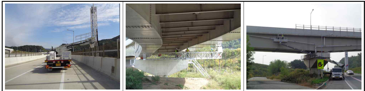
[고소작업차, 굴절점검차를 이용한 근접조사 실시]
