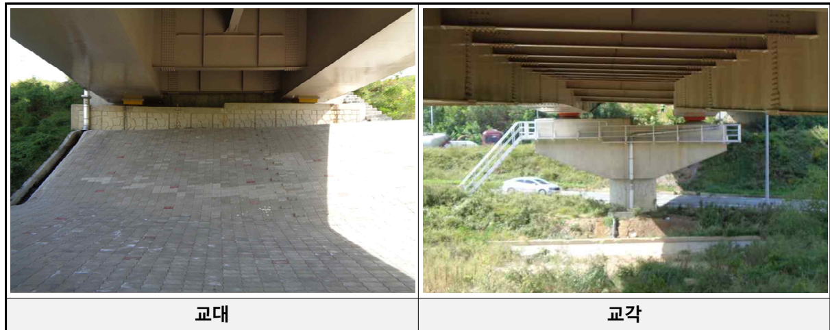
[교대 및 교각 전경]
